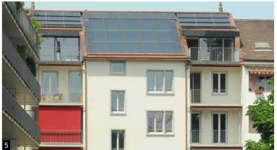
Abb. 5: Das sanierte 12-Familienhaus von 1896 in der Schutzzone Basel konnte den Gesamtenergiebedarf von 223'000 kWh/a um 91% auf 19'800 kWh/a senken.
