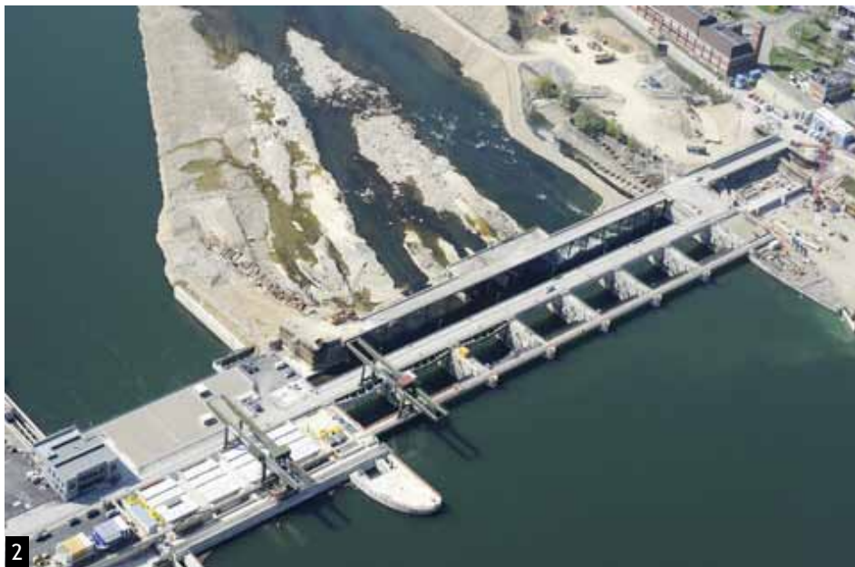
Abb. 2: Allein die vorbildliche Sanierung des Wasserkraftwerks Rheinfelden erbringt mehr Strom als die geplante Zerstörung der 10 schönsten Flusslandschaften von nationaler Bedeutung, wie die Greina.
