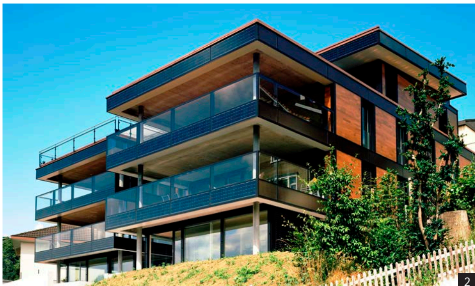
Abb. 2: Dieser 5-Familien-PlusEnergieBau (PEB) in Wil/SG benötigt 29'000 kWh/a und erzeugt 55'000 kWh/a. Mit dem Solarstromüberschuss können 17 Elektrofahrzeuge emissionsfrei betrieben werden. (Foto: Solar Agentur Schweiz, 2012).
