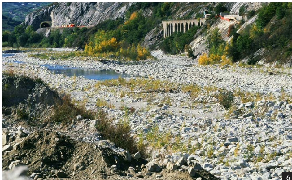
Abb. 6: Rotten bei Leuk/VS von den Rhonekraftwerken sehr stark genutzt. (Bild SGS, Sommer 2008).
