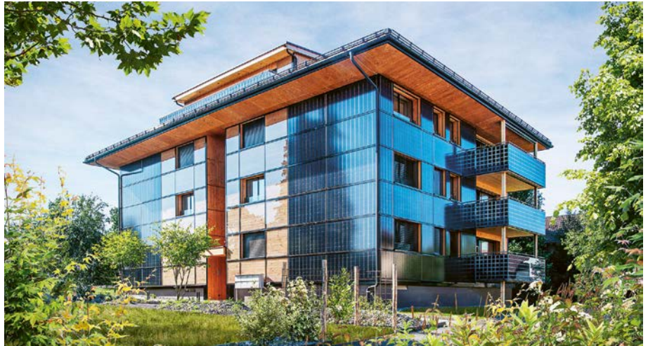
Abb. 3: Das 7-Familienhaus von 1974 in Fahrwangen/AG reduziert 82% Energieverluste, benötigt noch 25 000 kWh, erzeugt aber 78 000 kWh. Der CO 2 -freie Solarstromüberschuss von 53 000 kWh/a (315%) kann mittels Pumpspeicherkraftwerk (PSKW) hochgepumpt werden.
