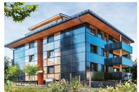
Abb. 2b: PEB-Sanierung 7 Fam.-Haus Fahrwangen AG. Dank optimaler Dämmung sank der Energieverbrauch pro Jahr von 138000 kWh um 82 % auf 25000 kWh. Das PEB-MFH erzeugt mit 78000 kWh einen Überschuss von 53000 kWh.
