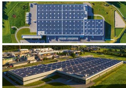
Abb. 2a: Logistikzentrum Perlen LU. Die PV-Anlage produziert jährlich 7,3 Mio. kWh und benötigt 3,1 Mio. kWh pro Jahr. Mit dem Solarstromüberschuss können 3000 E-Autos jährlich je 10000 km fahren.
