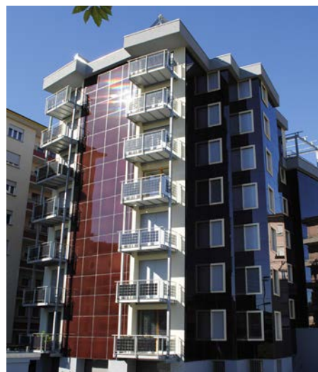
Abb. 4: Dank Minergie-P-Sanierung reduzierte dieses Hochhaus von 1965 seine Energieverluste um 88% von 503'000 kWh/a auf 62'500 kWh/a und produziert mit Dach- und Fassadensolaranlagen sogar gut 71'000 kWh/a und 14% mehr Strom, als es selbst braucht. Der Stromüberschuss beträgt 8'700 kWh/a. (Foto: Solar Agentur Schweiz 2014)
