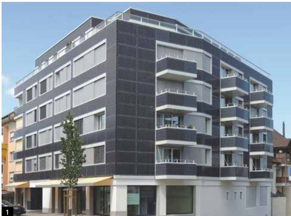
Abb. 1: Das 1962 errichtete Mehrfamilienhaus in Romanshorn/TG konsumierte rund 300'000 kWh/a. Seit der Sanierung benötigt es noch 84'000 kWh/a - und erzeugt zusätzlich 89'000 kWh/a! Dies obwohl die Anzahl Wohnungen von 6 auf 22 stieg und die Energiebezugsfläche um 56% zugenommen hat. (Bild: Solar Agentur Schweiz)
