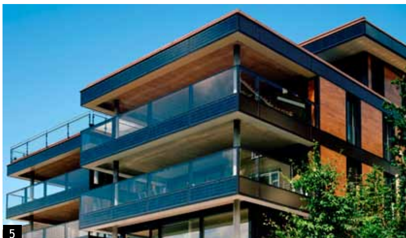
Abb. 5: Das PlusEnergie-Mehrfamilienhaus in Wil/SG erzeugt heute 186% des benötigten Energiebedarfs. Mit dem Solarstromüberschuss könnten 16 Elektrofahrzeuge solar und emissionsfrei betrieben werden.
