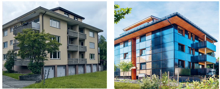
Abb. 4: Dank optimaler Dämmung sank der Energieverbrauch pro Jahr von 137 000 kWh um rund 80 % auf 25 000 kWh. Das PEB-MFH erzeugt mit 78 000 kWh einen Überschuss von 53 000 kWh pro Jahr. Der CO 2 -Ausstoss kann durch die Minergie-Sanierung um 33,5 t CO 2 pro Jahr reduziert werden. Die Senkung des CO 2 -Ausstosses durch die Verwendung von Solarstrom statt fossilen Energien beträgt 7,5 t CO 2 pro Jahr. Durch die Verwendung des Solarstromüberschusses für 35 E-Autos beträgt die Reduktion 84 t CO 2 pro Jahr.
