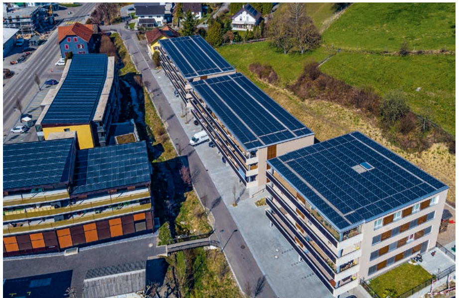
Abb. 2: 182%-PlusEnergie-Siedlung, 9555 Tobel/TG. 32 Wohnungen werden vollständig solar versorgt. Dazu kommt ein Stromüberschuss der ausreicht, um 77 E-Autos je 12000 km CO 2 -frei fahren zu lassen. Die Mietzinsen sind 20% niedriger als vergleichbare Wohnungen in der Region.
