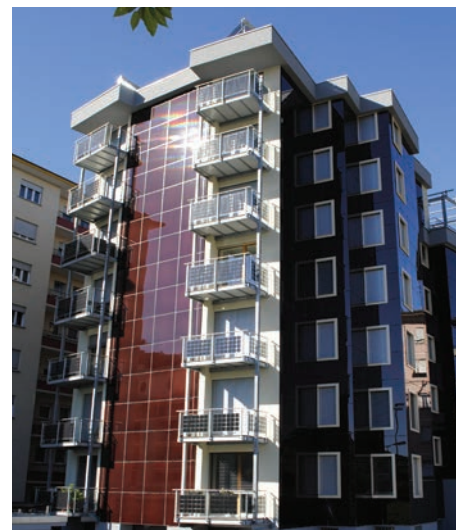
Abb. 6: Mit der Sanierung sank der Energieverbrauch dieses Hochhauses von 1965 um 88% von 503'000 kWh/a auf 62'500 kWh/a. Dach- und Fassadensolaranlagen produzieren 71'000 kWh/a. Der Stromüberschuss beträgt 14%. (Foto: Solar Agentur Schweiz)
