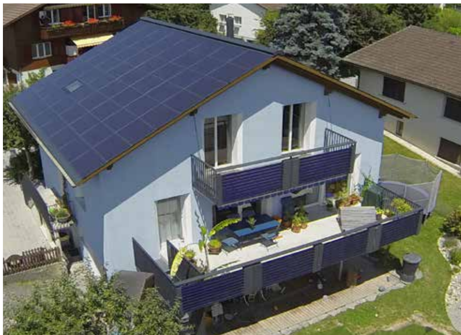
Abb. 3: Dieses Einfamilienhaus in Hünibach/BE erzeugt nach etappenweiser Sanierung dank Solaranlagen auf dem Dach und an der Balkonbrüstung gut 200% mehr Strom, als es selbst braucht (Foto: Solar Agentur Schweiz)
