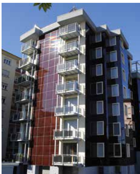
Abb. 4: Dank Minergie-P-Sanierung reduzierte dieses Hochhaus von 1965 seinen Energieverbrauch um 88% von 503'000 kWh/a auf 62'500 kWh/a und produziert mit Dach- und Fassadensolaranlagen sogar gut 71'000 kWh/a. Der Stromüberschuss beträgt 8'700 kWh/a oder 14%. (Foto: Solar Agentur Schweiz)
